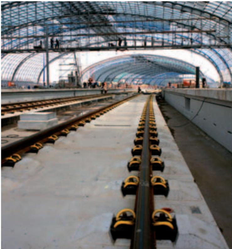
Auf der Stadtbahn im Hauptbahnhof wurde eine extrem flache Bauart der Festen Fahrbahn eingebaut.
