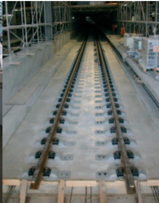
Feste Fahrbahn auf Masse-Feder-System im unterirdischen Bahnhofsbereich
