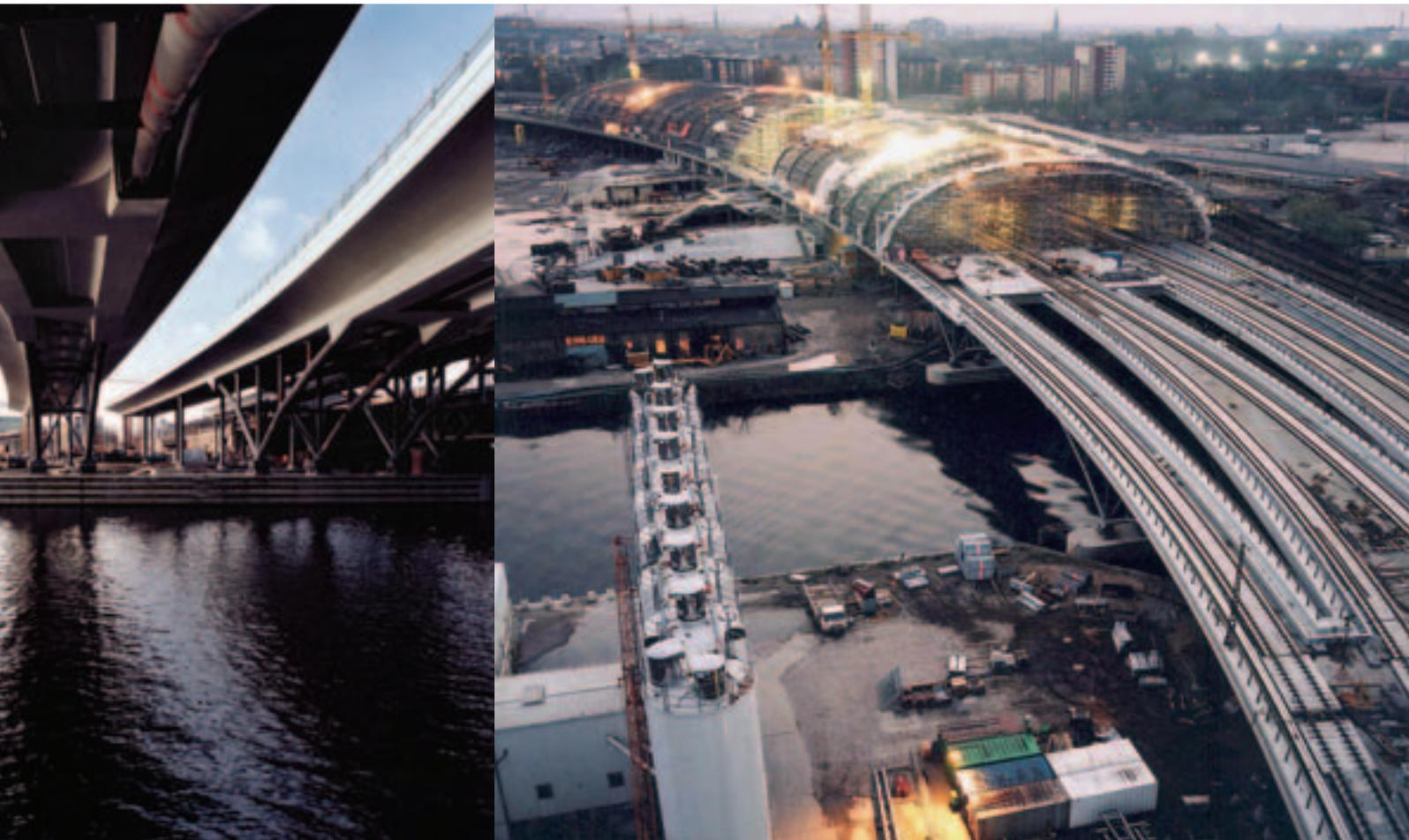
Der ein Kilometer lange Brückenzug besteht aus 64 Einzelbrücken. Selbst das einzigartige Glasdach ist auf den Brücken gelagert.
