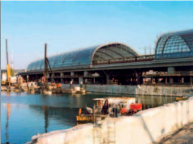
**2003: Die Unterwasserbetonsohle der letzten Baugrube wird eingebracht.**
